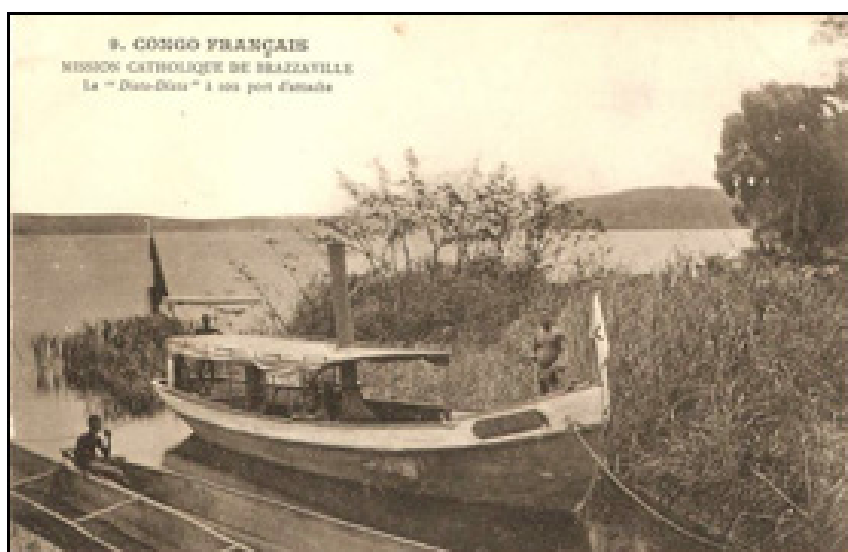
Le Diata-Diata à son port d'attache avec sa chaudière nouvellement installée, arborant le pavillon blanc à croix bleue, emblème de la Mission et le pavillon français à l'arrière.
