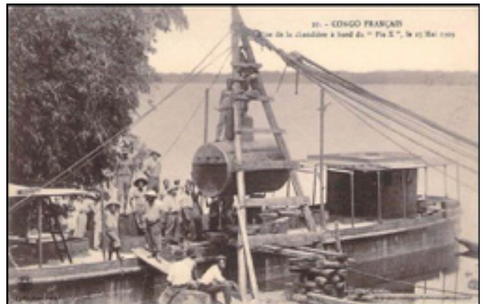
Construction du Pie X, sur cales, puis à l'eau avec la mise en place de la chaudière. On remarquera sur la première carte postale Mgr Augouard et le Père Allaire, tour à tour charpentier, forgeron...
