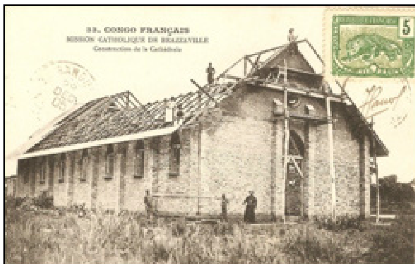
Construction de la cathédrale de Brazzaville, en briques.
